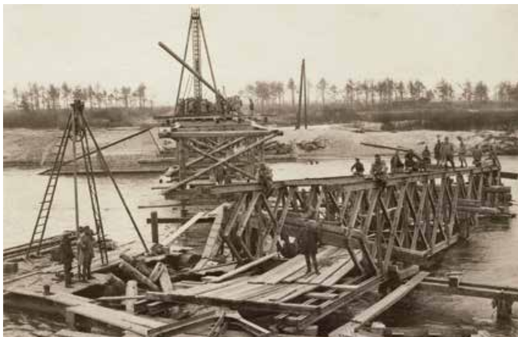
Most kolejowy na Sanie w Kępie Rzeczyckiej, w trakcie odbudowy przez wojsko austro-węgierskie. Ze zbiorów Muzeum Regionalnego w Stalowej Woli
