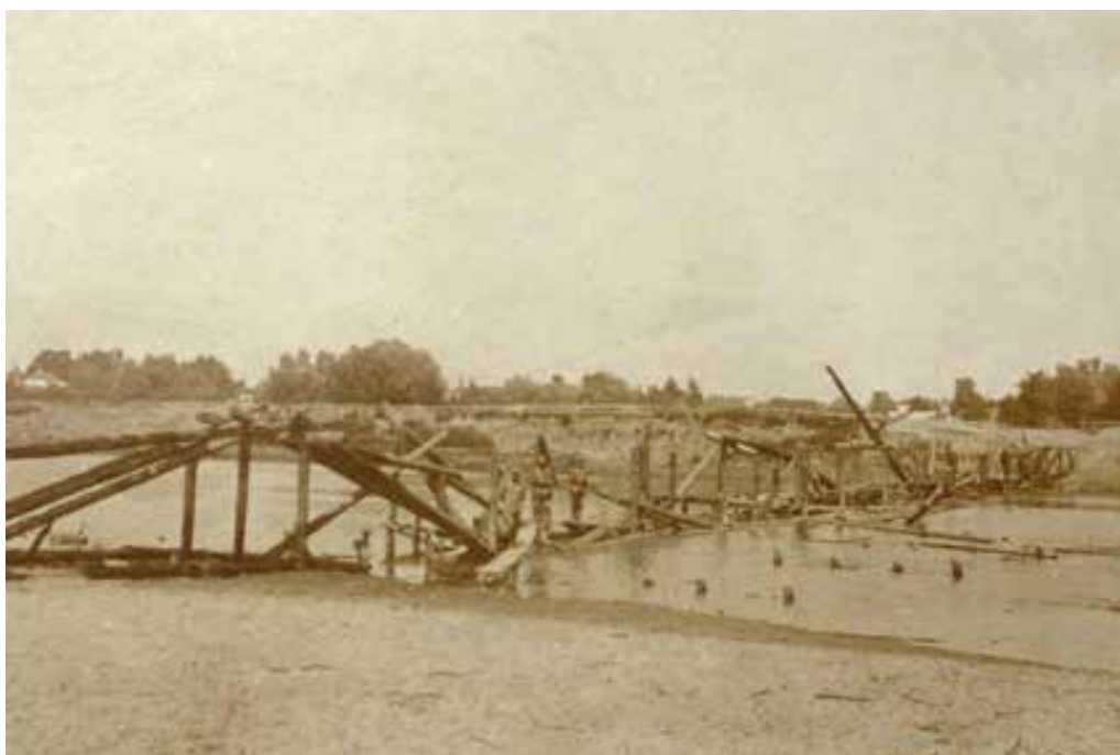
Zniszczony most na Sanie pod Ulanowem, 28 czerwca 1915.
