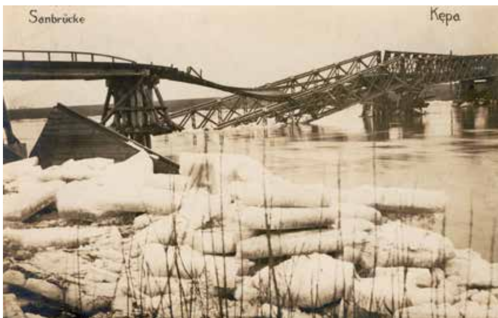
Most kolejowy na Sanie w Kępie Rzeczyckiej, zniszczony podczas działań wojennych. Ze zbiorów Romana Wydry
