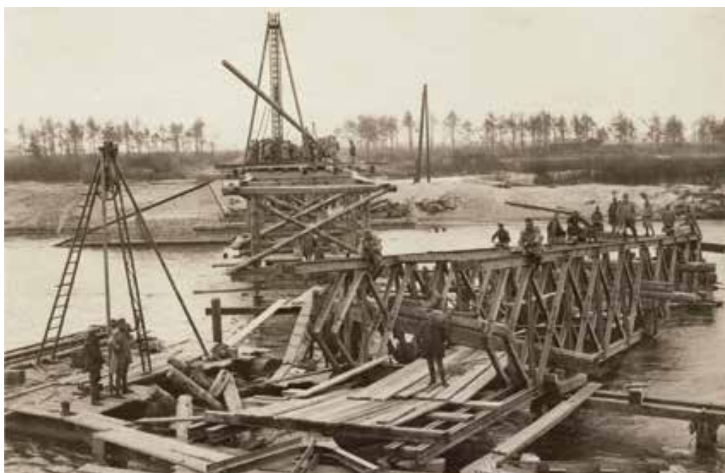
Most kolejowy na Sanie w Kępie Rzczyckiej, w trakcie odbudowy przez wojsko austro-węgierskie. Ze zbiorów Muzeum Regionalnego w Stalowej Woli
